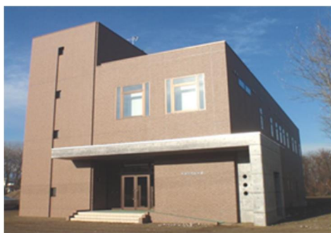
新港中央配水場
