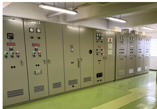
写真6－2 更新された配水ポンプ及び計装盤
