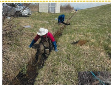
↑ 側溝水路の 清掃作業
