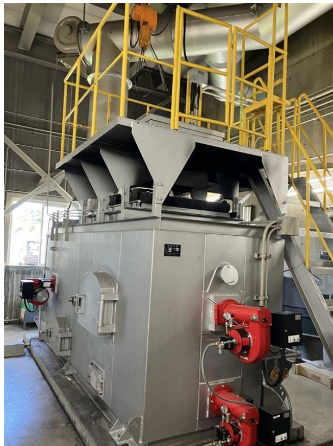
図 6-5 既存小動物焼却施設の外観
