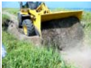
(侵食穴の埋め戻し)
