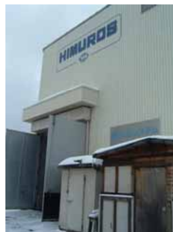
図 5.8 雪冷房貯蔵庫 (石狩市の事例)
