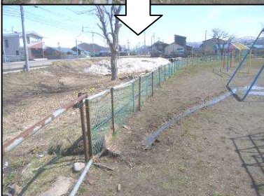
岸本産業㈱のご協力により、浜益小学校グラウンドの倒れたフェンスの修復が行われました。
