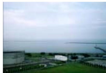
かつての砂浜に建った火力発電所の敷地内。
