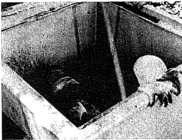
排水樹コア抜き
