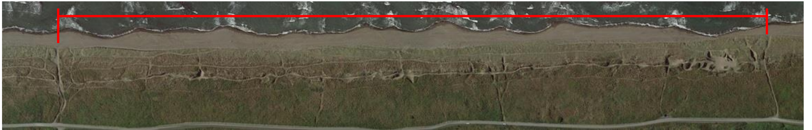
現況写真 (H26)
