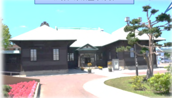
旧樺戸集治監本庁舎
