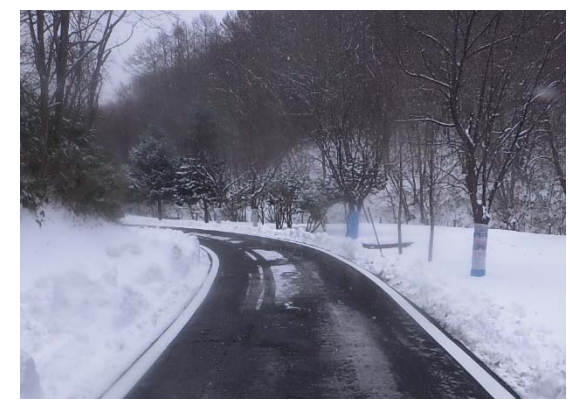
林道八幡沢線改良
