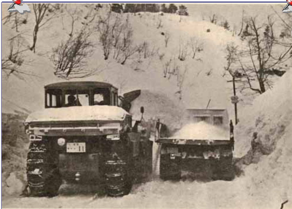
陸の孤島解消～青山隧道附近の除雪の様子
