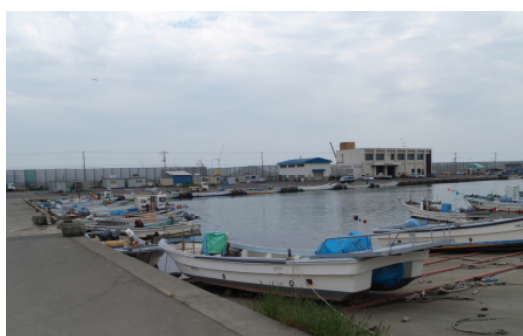
写真-12 混雑する岸壁(石狩湾新港)
