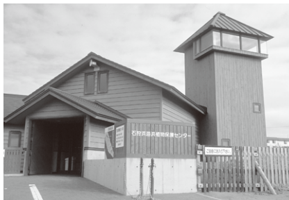
石狩浜海浜植物保護センター
