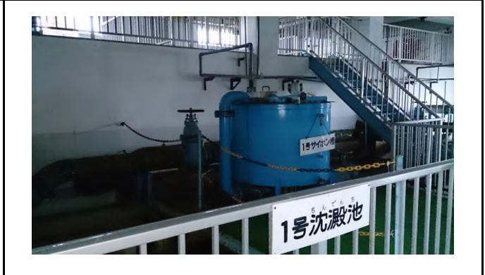
建屋2F(沈殿池付近)
