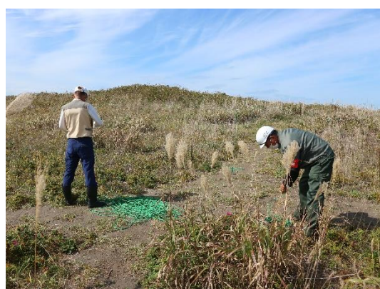
誘導ロープの撤去作業
