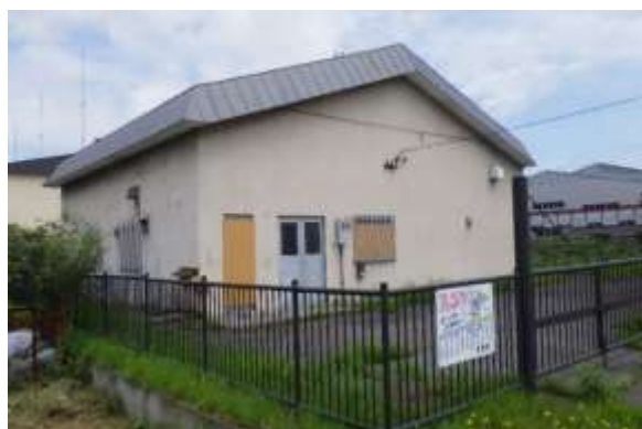
④新港南浄水場
