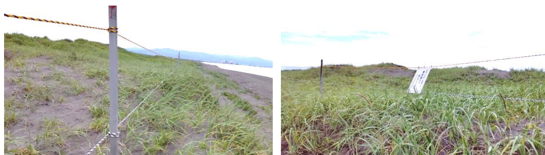
写真：親船地区ロープ修理後の様子
