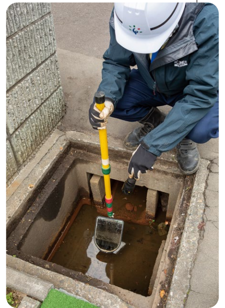
路面ますが詰まっていないか鏡で定期的に確認
