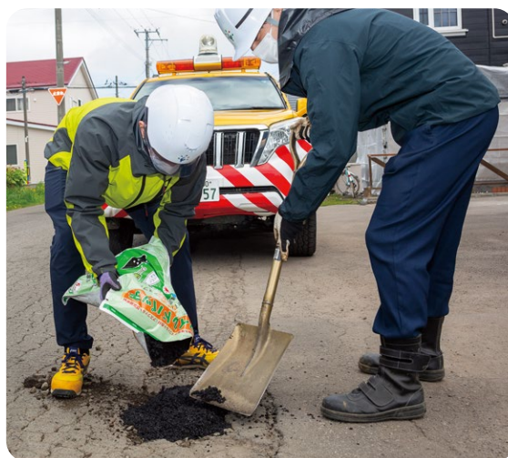
常温で固まるアスファルトの補修材で穴を埋める様子
