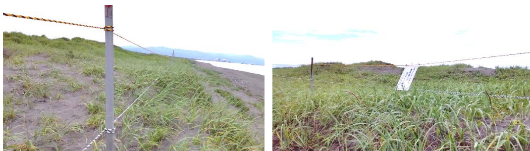
写真：親船地区ロープ修理後の様子
