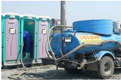
写真 4-5 仮設トイレの状況（出典：（一財）消防科学総合センター「災害写真データベース」）
