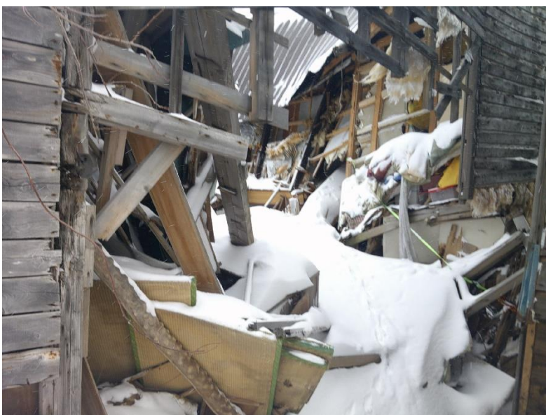
外壁破損・屋根崩落状況 (裏側・海側)
