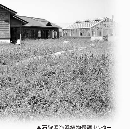
▲石狩浜海浜植物保護センター
