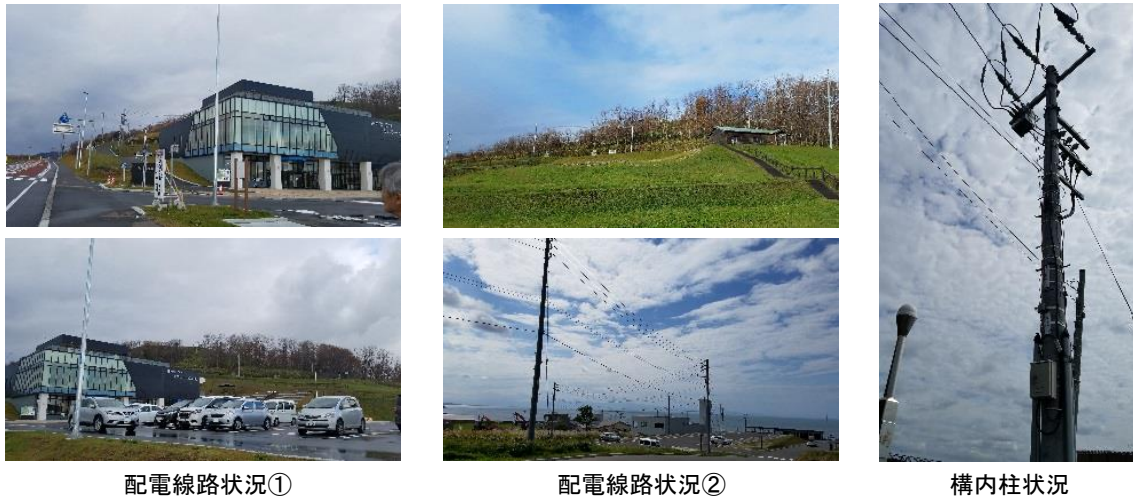
図10. 道の駅石狩あいろーど厚田現地調査の様子
