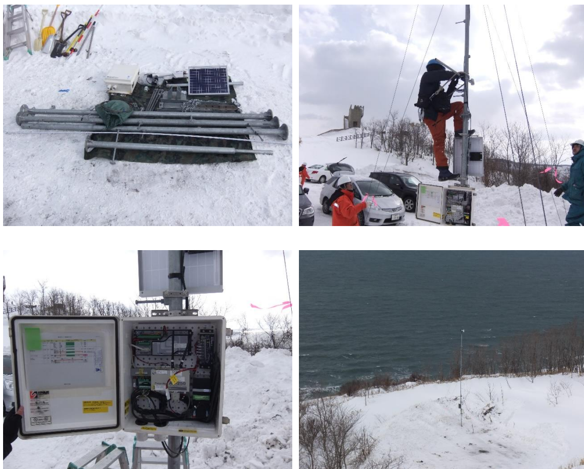
図25. 測定器設置の様子
